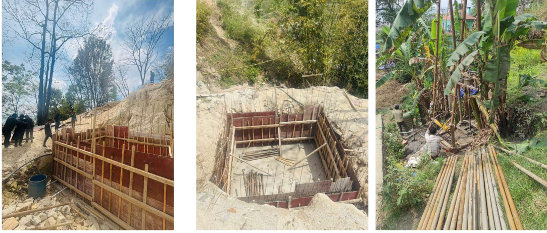
भोर्लाबोटमा RVT निर्माण कार्य तथा कार्की हाइटमा बोरिंग निर्माण कार्य
