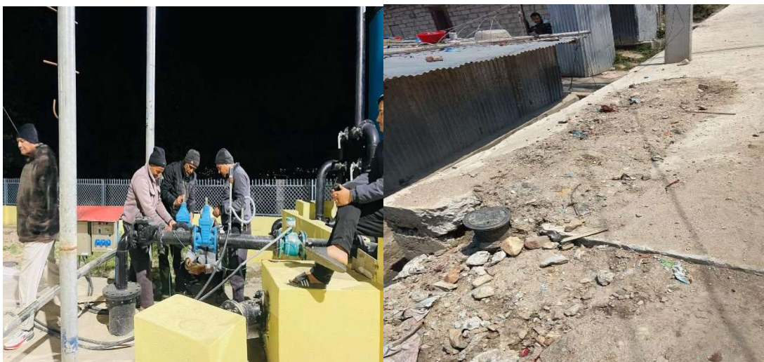
Final phase अन्तर्गत testing, valve जडान तथा मर्मत कार्यहरू
