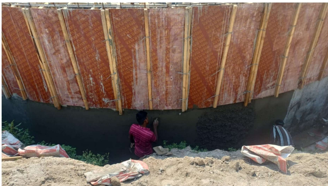
Semi UGTको ढलान तथा plastering कार्य
