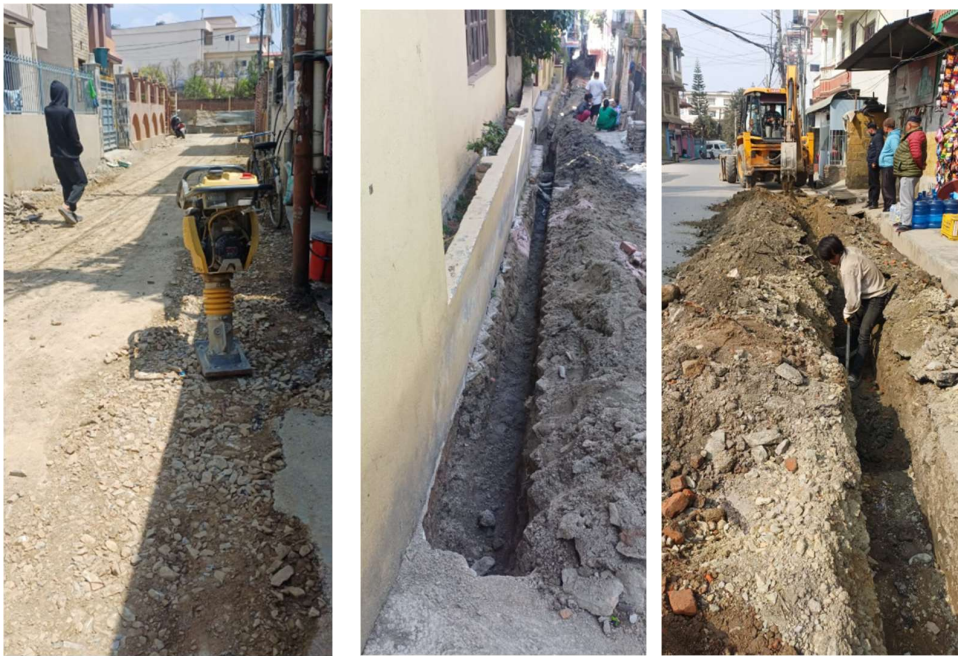
Excavation, pipeline बिछ्याउने कार्य तथा बसेवोर्क for reinstatement
