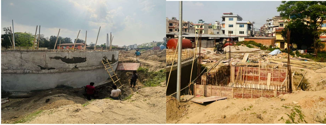
निर्माणाधीन UGT तथा pump house
