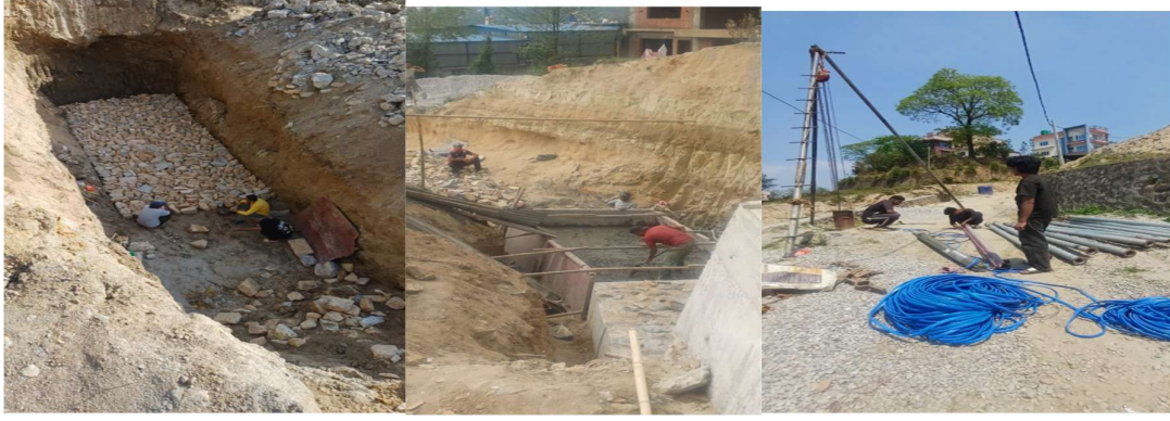
Plum wall निर्माण कार्य तथा बोरिंगमा pump जडान कार्य
