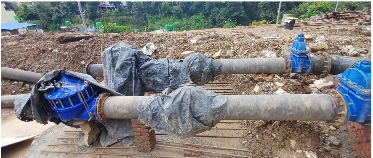
SCADA जडान कार्य
