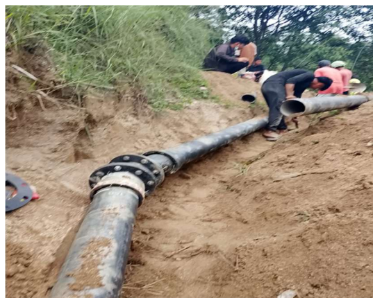
D pipe बिछ्याउने कार्य
