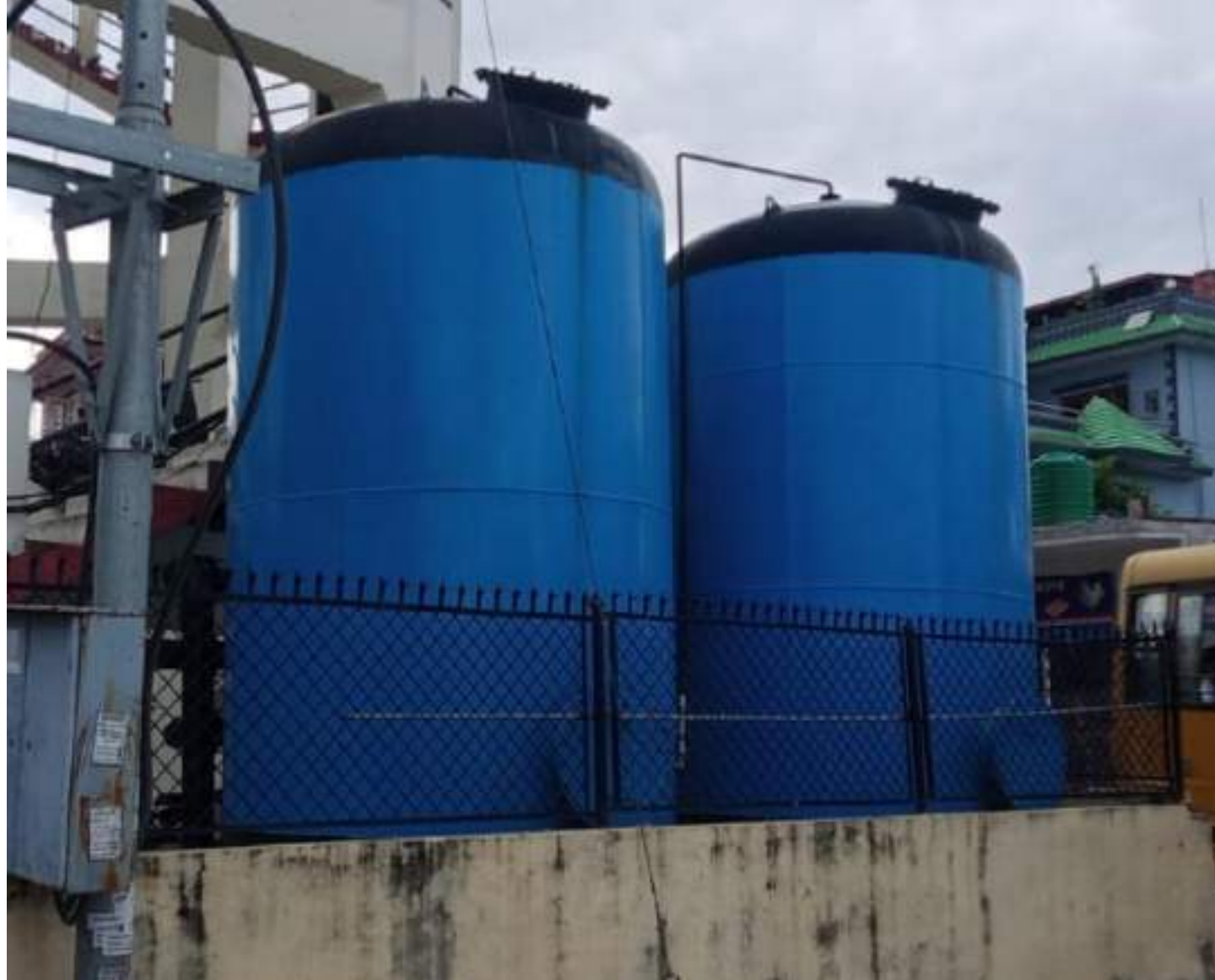
निर्माण सम्पन्न Multigrade pressure filter(१५ -२० lps) काँडाघारी खानेपानी तथा सरसफाई आयोजना
